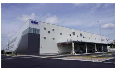
下妻第二工場
